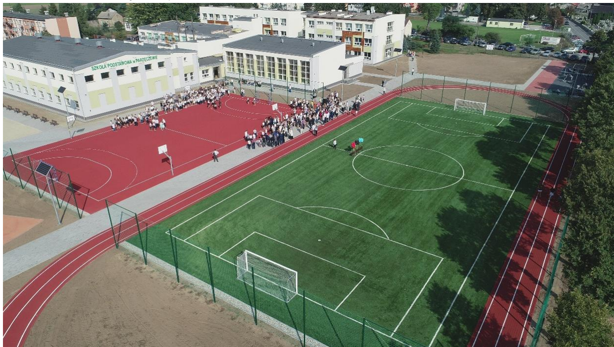
Fot. Kompleks sportowy przy Szkole Podstawowej w Parzęczewie. Wartość prac 1 920 936,26 zł.
