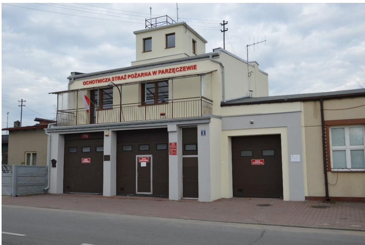
Fot. Budynek Ochotniczej Straży Pożarnej w Parzęczewie po termomodernizacji Wartość prac 133 160,82 zł
