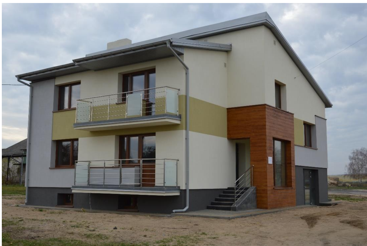
Fot. Budynek komunalny przy ul. Rocha w Parzęczewie po termomodernizacji Wartość prac 241 715,04 zł
